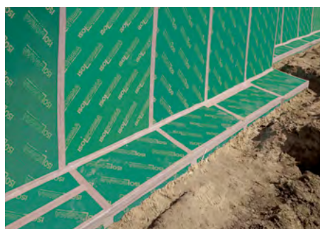
Fondation d'un complexe résidentiel, Pologne.
